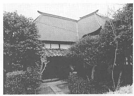
綿貫家住宅正面
